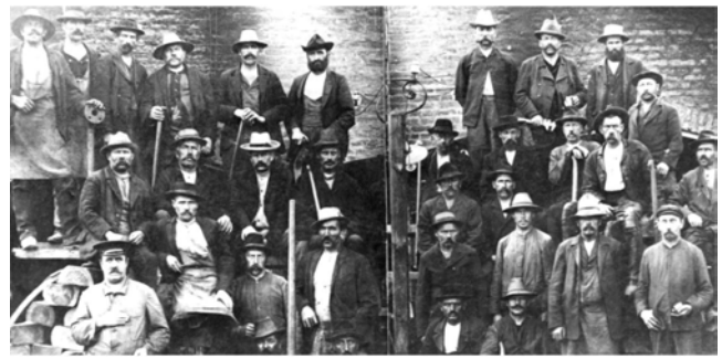
Schwellewerk-Arbeiter im Jahr 1908
